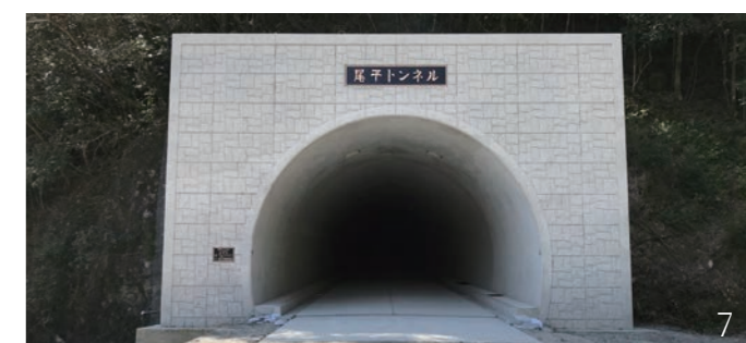
写真7 尾平トンネル（東臼杵郡椎葉村大字松尾）(JV)
