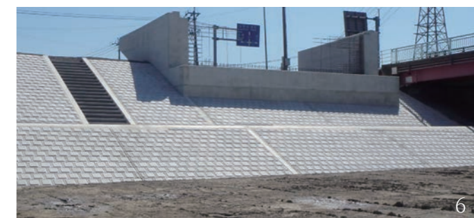
写真6 本庄橋橋梁下部工（東諸県郡国富町大字本庄）(JV)
