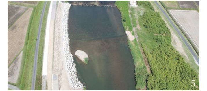
写真5 えびの地区河道整備（ICT 優秀施工業者受賞）
